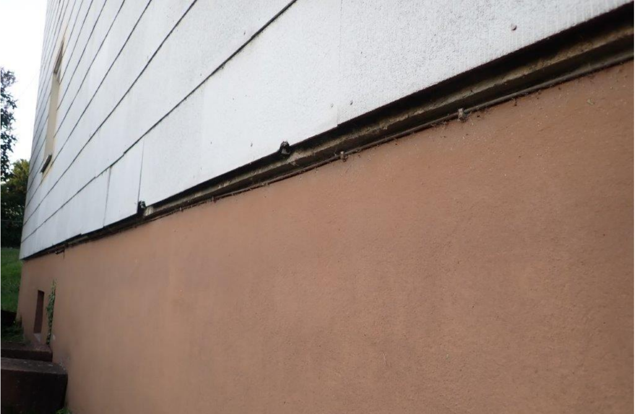
Abbildung 6: Westliche Giebelseite der Hausnummer 21. Die Eternitverkleidung ist mit Steinwolle hinterfüllt. Es ergaben sich keine Hinweise auf Verstecke oder Hohlräume hinter der Verkleidung an den Gebäuden (Foto: Moos, Juni 2022).
