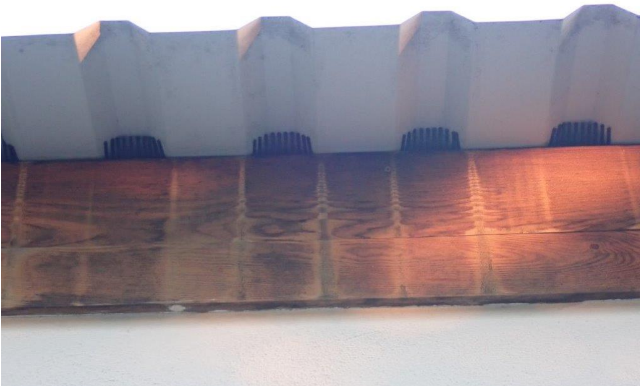
Abbildung 8: Die Hohlkehlen der Profilblecke wurden an den Garagen mit Kämmen aus Kunststoff verschlossen, so dass Kleintiere keinen Zugang haben (Foto: Moos, Juni 2022).
