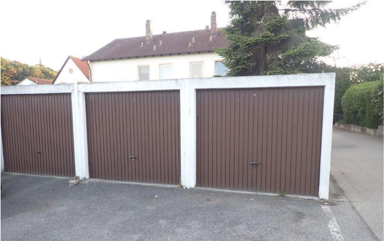
Abbildung 9: Die Garagen im Westteil sind in Fertigbauweise aus Beton hergestellt und haben keine Nischen oder sonstige Versteckmöglichkeiten (Foto: Moos, Juni 2022).
