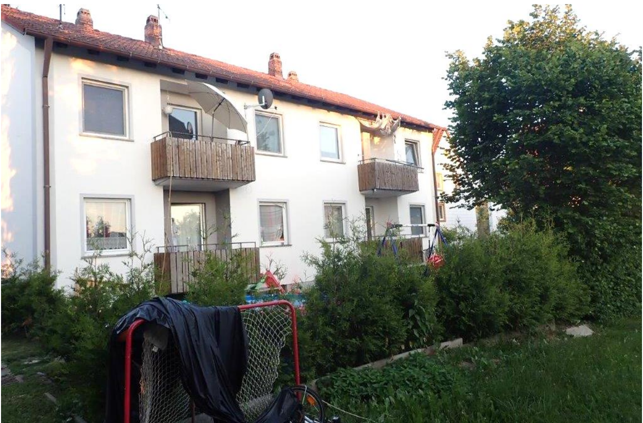
Abbildung 2: Westseite der Hausnummer 16 mit Balkonen. Die Bauweise der Balkone „ergibt“ keine
