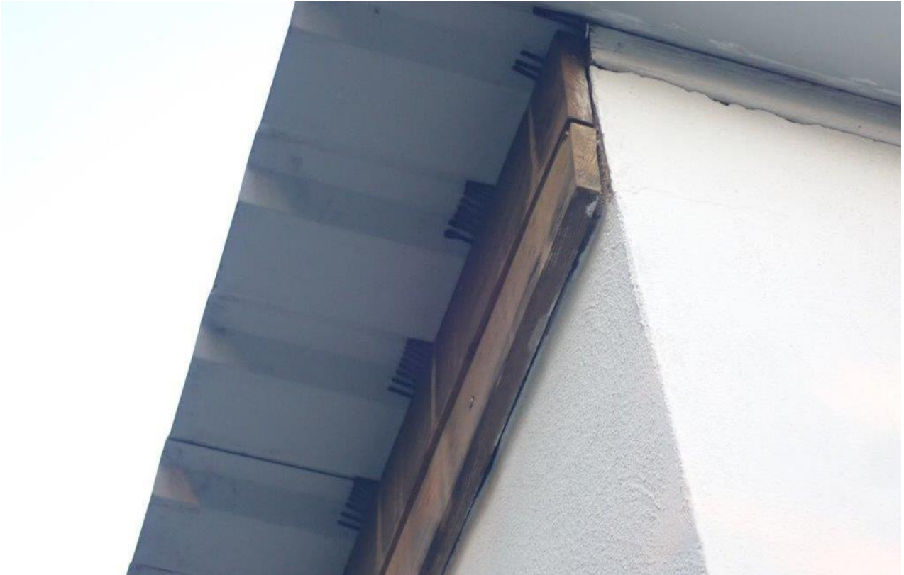
Abbildung 7: Holzverschalung an den Garagen im Westen von Ziegelfeld II. Die Bretterverschalung bietet keine Nischen oder Verstecke. Sie wurde offensichtlich angebracht, um den Zugang von Vögeln oder anderen Tieren zu unterbinden (Foto: Moos, Juni 2022).
